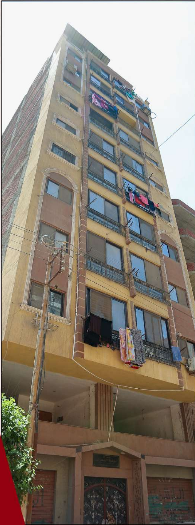
لؤلؤة البحري - شارع البحري بالإسماعيلية ، المالك : شركة مكة تم عمل التصميم الإنشائي وإشراف على التنفيذ لبرج تجاري سكني
