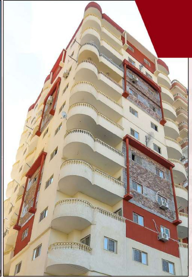
برج عبد الخالق - شارع المستشفى بالإسماعيلية , المالك: أوشن للإستثمار العقاري تم عمل التصميم الإنشائي والتجفيف وإشراف وتنفيذ لبرج تجاري سكني
