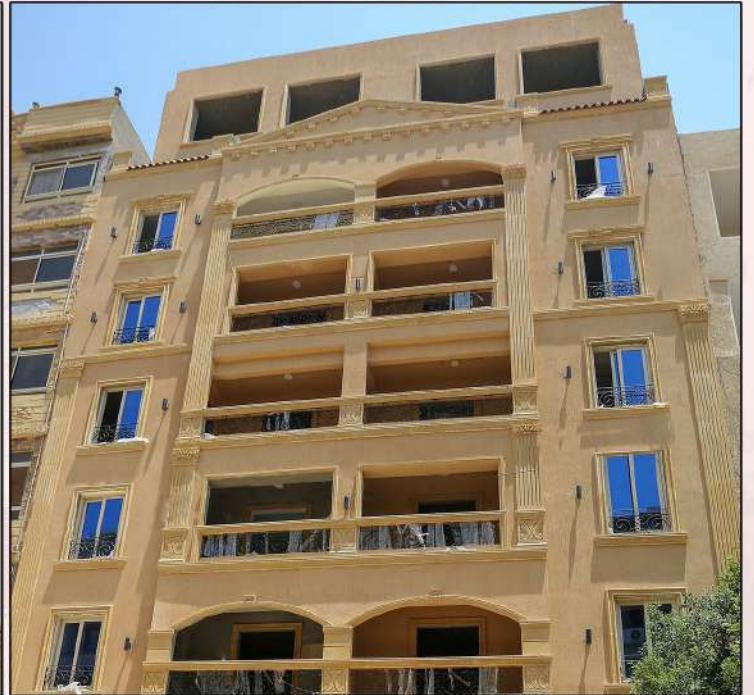
عمارة الجامعة 7 - شارع 7 الجامعة القديمة بالإسماعيلية , المالك : Techno تم عمل التصميم الإنشائي وإشراف وتنفيذ لبرج تجاري سكني
