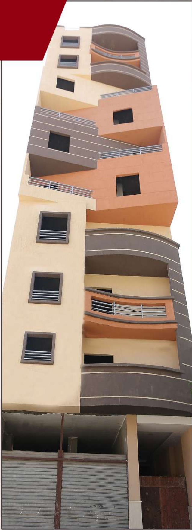
برج العبد - شارع المنصورة بالإسماعيلية , المالك : الحاج سيد العدوي تم عمل التصميم الإنشائي وإشراف وتنفيذ لبرج تجاري سكني
