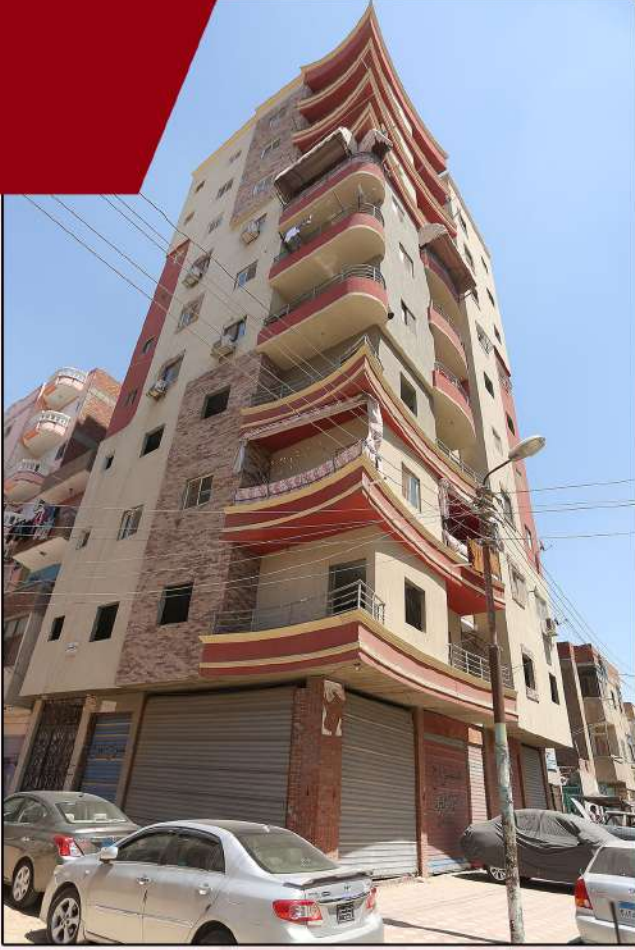
برج الغمري - شارع دمنهور بالإسماعيلية , المالك : شركة اوشن تم عمل التصميم الإنشائي وإشراف وتنفيذ برج تجاري سكني
